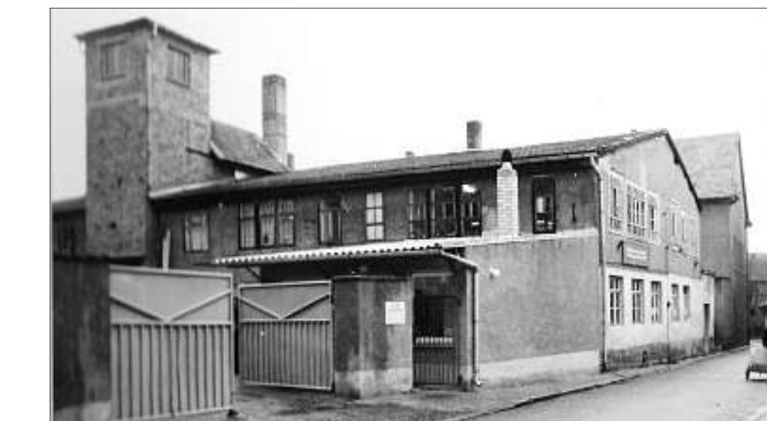
Alte Gebäude: Der ehemalige Hauptstandort des VEB Elektro Bad Frankenhausen in der Rittergasse. 1989 hatte der Betrieb rund 100 Mitarbeiter.
