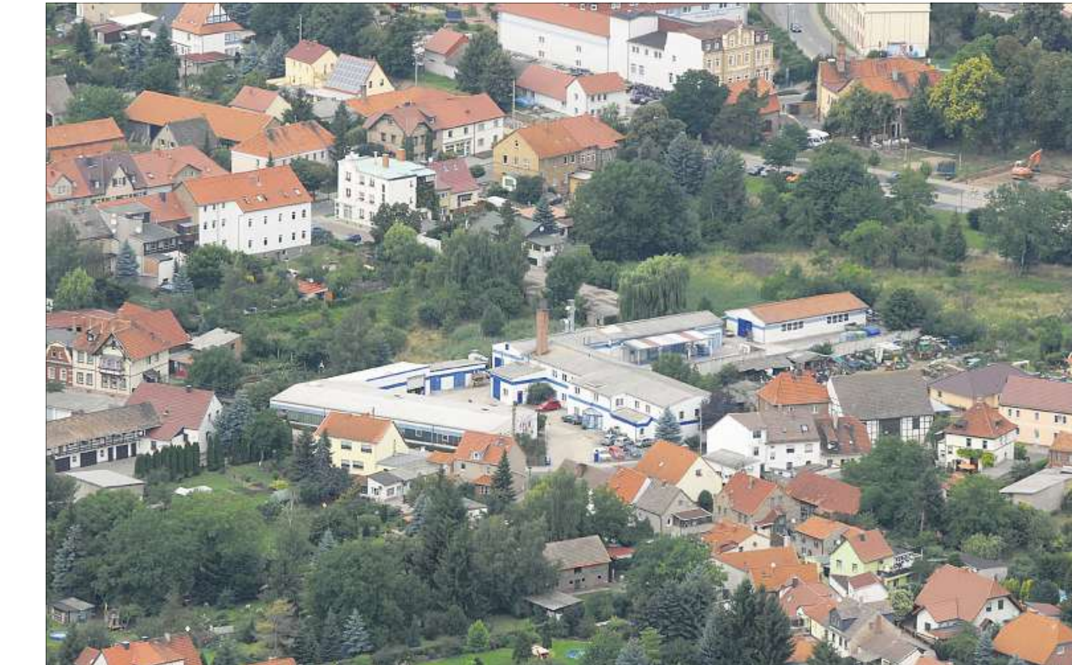
Die Linn Elektro Therm GmbH in Bad Frankenhausen. Der Neubau entstand 1994 und ermöglichte den Bau größerer Ofenanlagen und Investitionen in moderne Maschinen.
